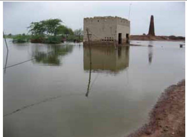
2006年夏の洪水でMirpur Khas周辺でもLBODが決壊。写真は浸水したレンガ工場
