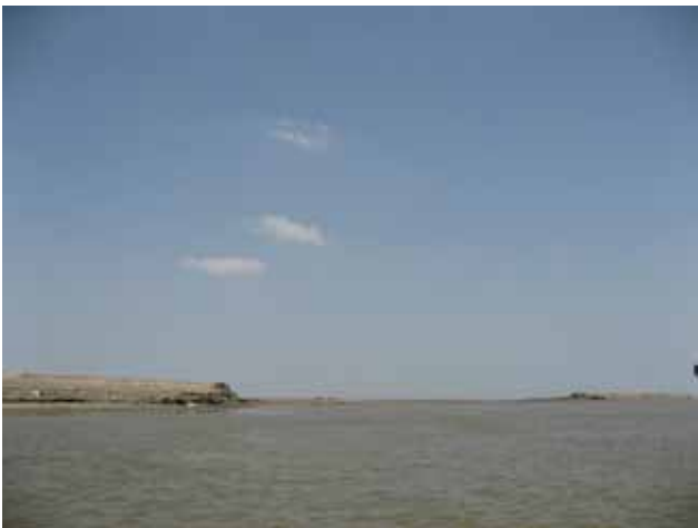
決壊した河口部の排水路「Tidal Link」。修復は完全に放棄されている
