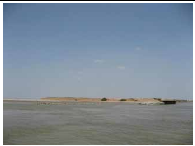
決壊した「Cholri Weir」の跡
