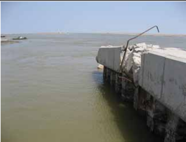
1999年のサイクロンで決壊した洪水緩和用の貯水池水門「Cholri Weir」の跡
