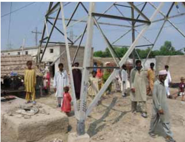
高圧鉄塔の周辺にも家屋が建てられている
