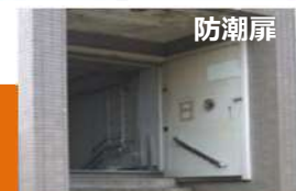
地下鉄出入口の浸水対策
