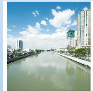
改修を行ったバッシング・マリキナ川 （フィリピン）
