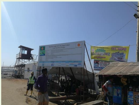
バングラデシュのマタバリ石炭火力発電事業予定地での現地調査
