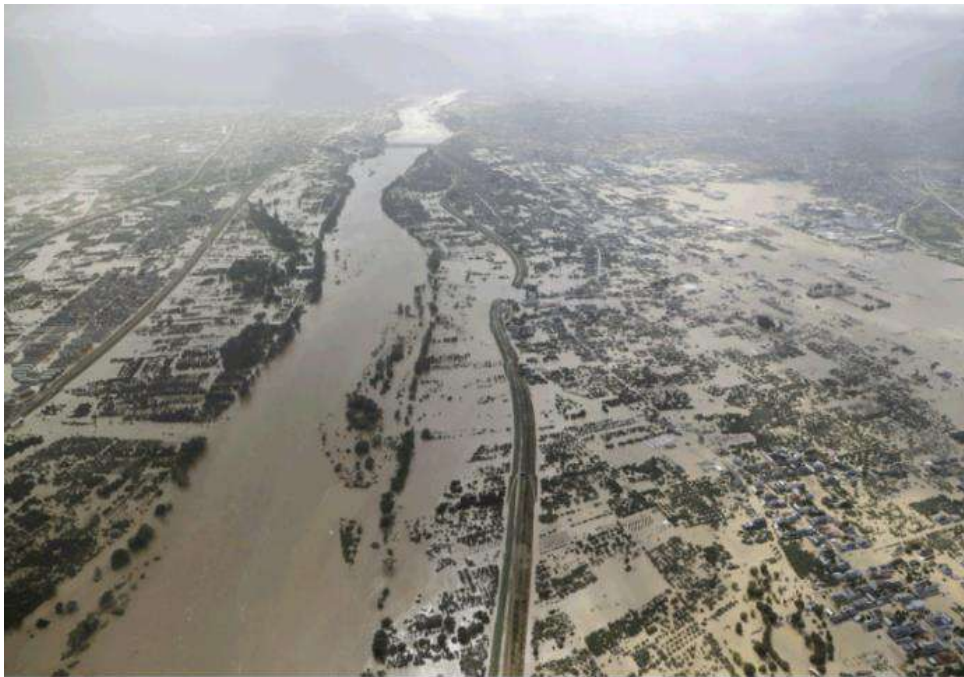
▲令和元年東日本台風による被害の様子 ＜長野県長野市千曲川＞
