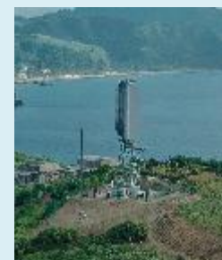
▲垂直軸型マグナス風力発電機 10kW実証機（フィリピンバタン島）
