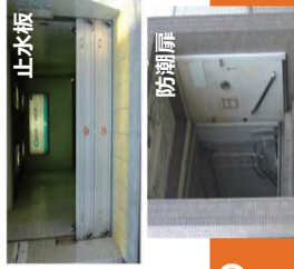
地下鉄出入口の浸水対策
